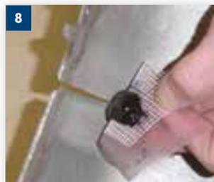
**8** Bringen Sie die Tander®-Gitter verstärkte Folie oder Formfolie auf. Beginnen Sie damit auf der Rückseite des präparierten, beschädigten Bereichs, üben Sie sanften Druck aus und sorgen Sie für eine gleichmäßige Verteilung mit Hilfe des Colad-Spachtels.
