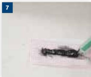
**7** Tragen Sie das Tander® Kunststoff-Klebmittel auf die Tander®-Gitter verstärkte Folie oder Formfolie auf. Stellen Sie sicher, dass sich die Düsen Spitze immer im Produkt befindet. So verhindern Sie Luftbläschen im Klebmittel, die zu Luftbläschen beim Auftragen führen könnten.
