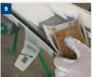
**9** Sobald das Tander® Kunststoff-Klebmittel ausgehärtet ist (siehe technische Daten), schleifen Sie die Oberfläche mit dem Colad Soft Flex P180 ab.
