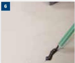
**6** Drücken Sie vor dem Auftragen des Tander® Kunststoff-Klebmittels eine kleine Menge heraus, um für die richtige Durchmischung zu sorgen.
