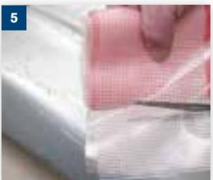
**5** Bringen Sie die Tander®-Gitter verstärkte Folie oder Formfolie durch Zuschneiden mit einer herkömmlichen Schere auf die gewünschte Größe.
